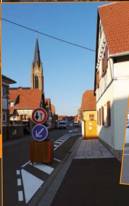
Mise en place de panneaux de signalisation
