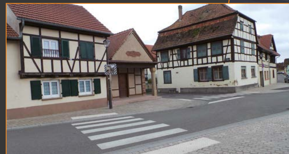
Accès mairie et écoles nouveaux passages piétons et nouveau miroir
