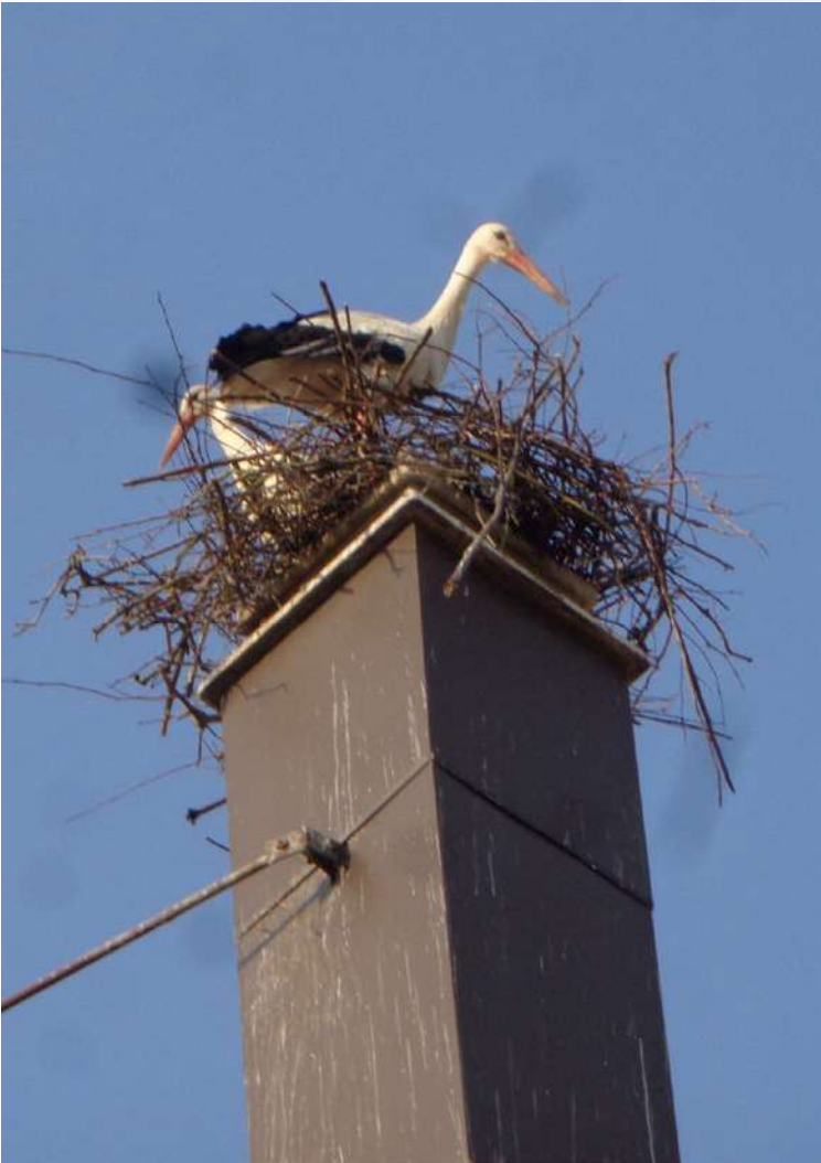
Visite imprévue sur la cheminée de l'église
